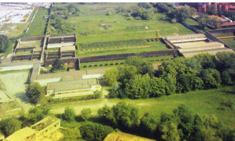
VEDUTA AEREA DEL POLIGONO
